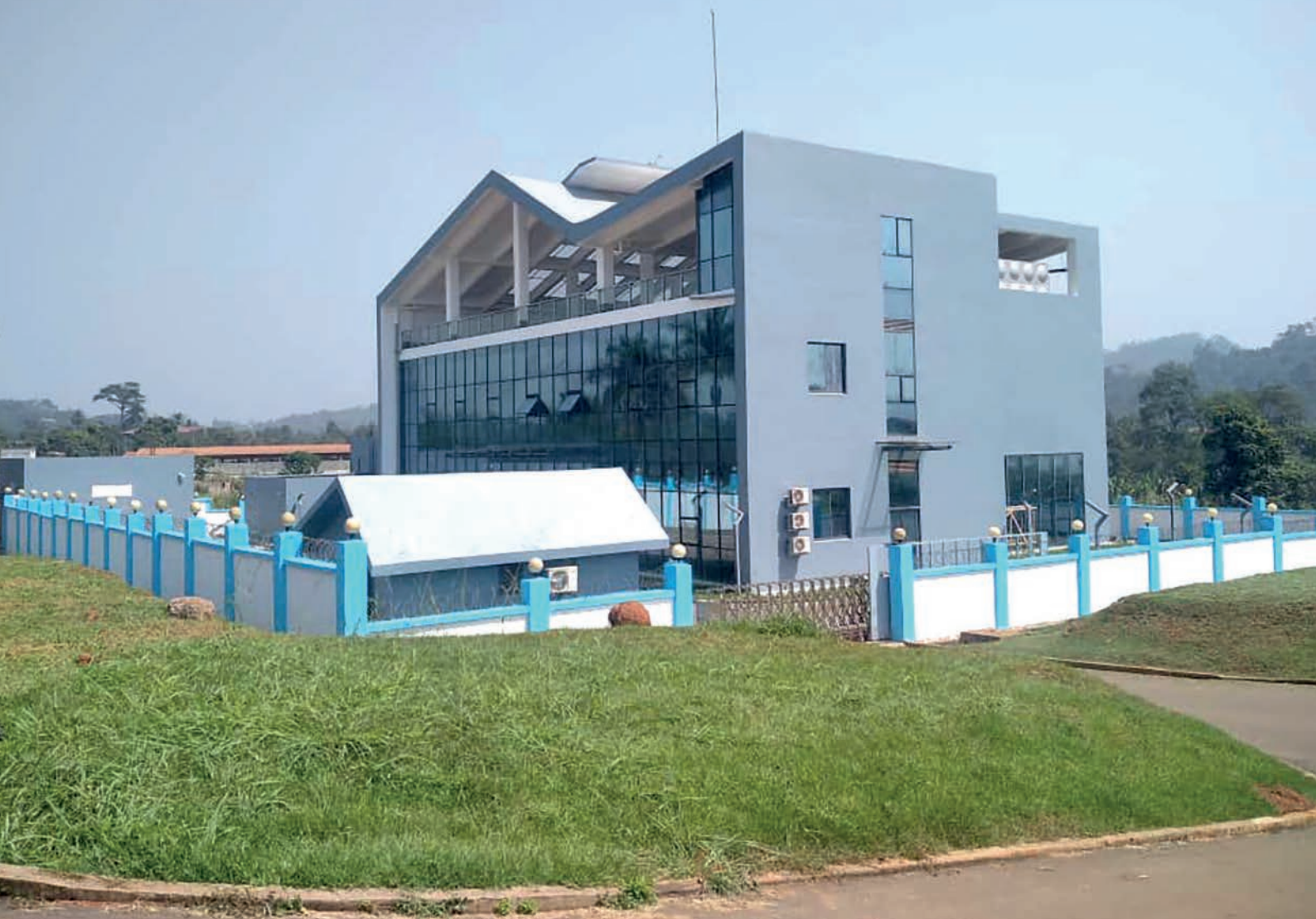
➤ Le Data Centre de CAMTEL à Zamengo.
